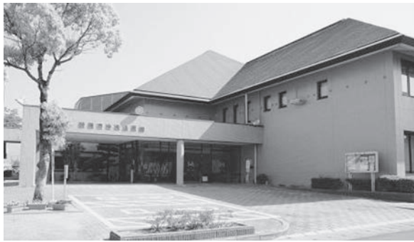
▲改修工事に取り組む神崎市中央公民館
