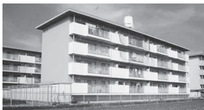
▲外壁改修が行われた東野ヶ里団地
