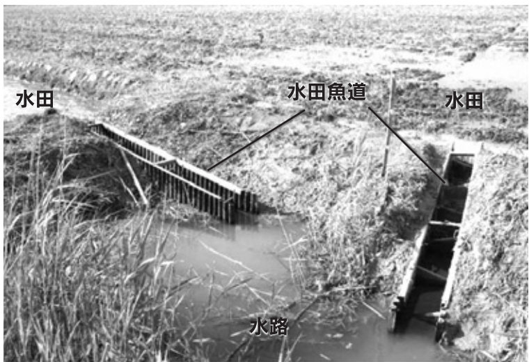
水田魚道の施工例
