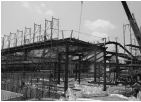
▲西郷保育園建設工事
