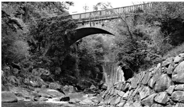
工事は明治23年に着工し、明治25年に完成しました。総工費875円(当時、白米10kg25銭)で、幅員6m、長さ20m、橋脚は、両岸の岩盤に固定され、耐久性と急流の負荷を少なくするたためにアーチの構造を持つ石造の橋として建設されました。
