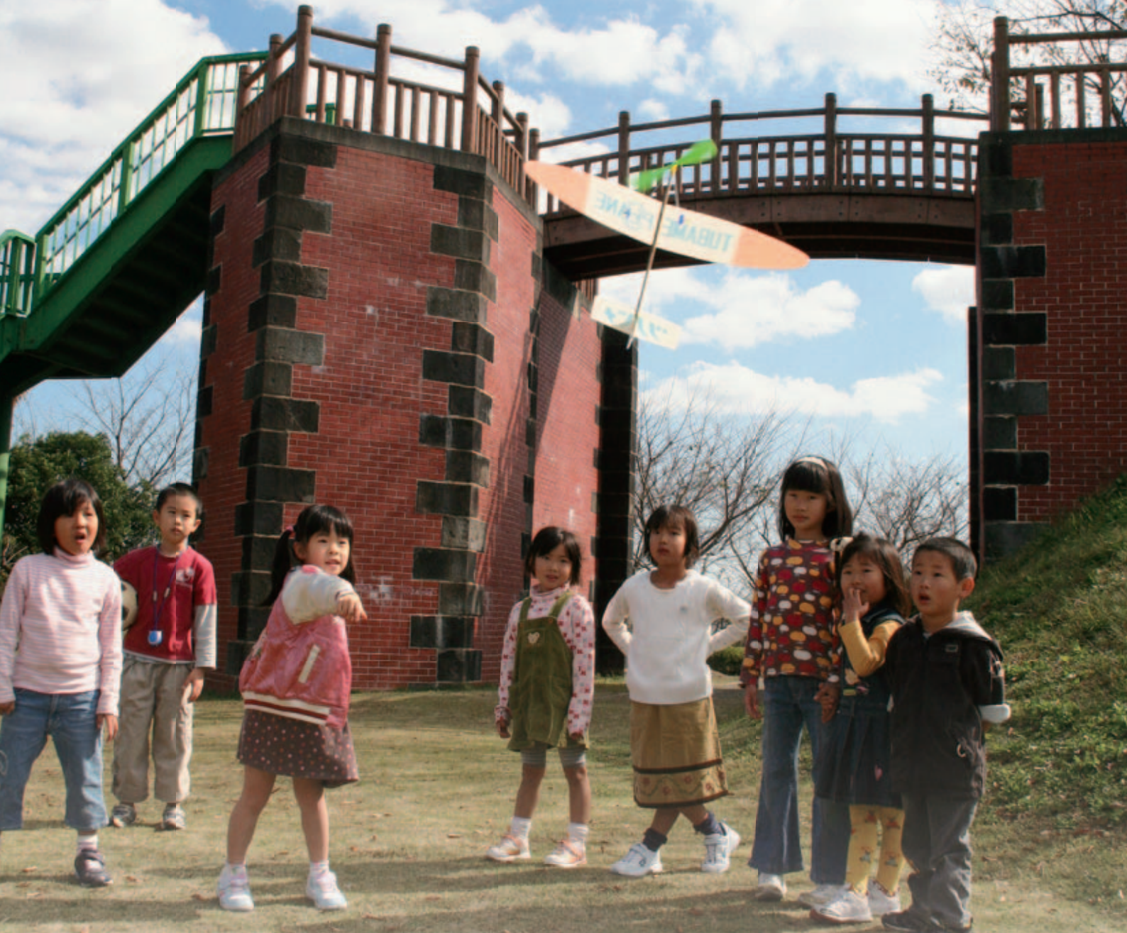
次郎の森公園内にある埧水門（千代田町）
