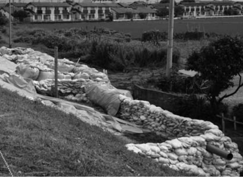
▲神陽団地付近で行われた水防活動「月の輪工法」
