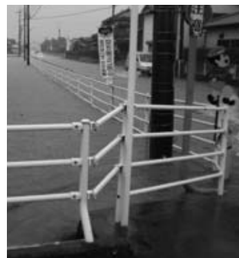
▲川の水があふれ冠水した県道(石井ヶ里)
