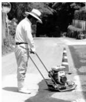
▲道路補修作業中
