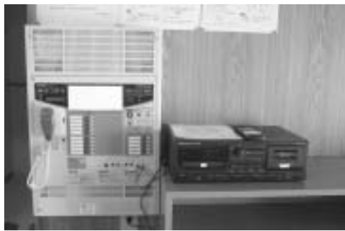
▲犬の目地区（屋外放送施設）
