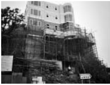
▲竹で作った建築現場の足場
