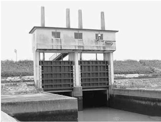
国営出来島排水樋門
