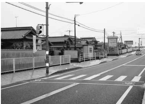
危険な傾斜が続く千代田総合支所前歩道
