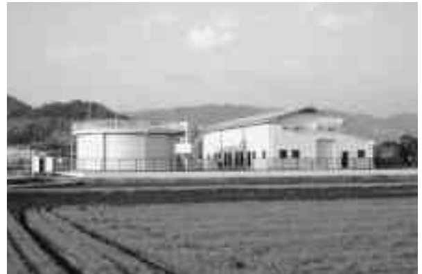
城原金立ポンプ揚水機場
