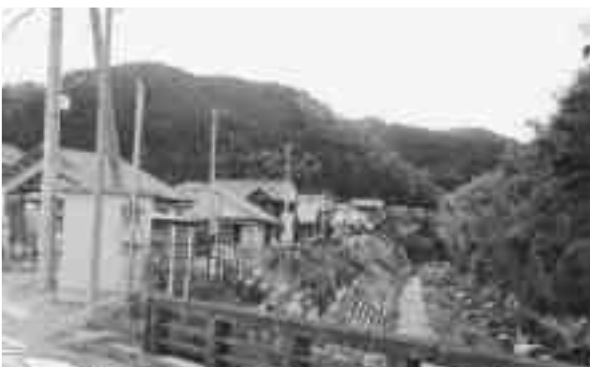
ふるさと定住宅地造成事業による脊振町広滝西地区団地
