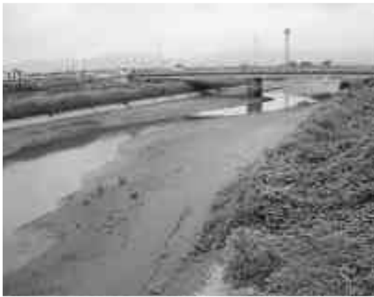
城原川（千代田町中央大橋付近）
