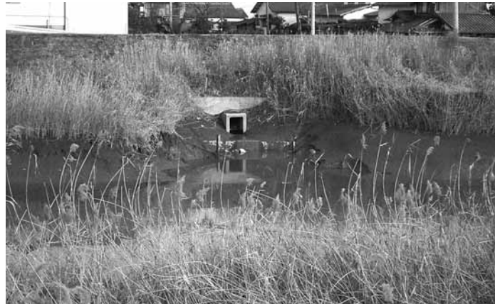
柴尾橋本樋管
