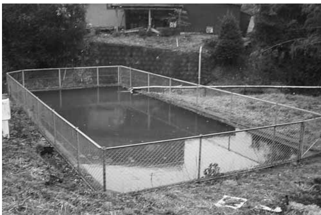
脊振地区防火水槽
