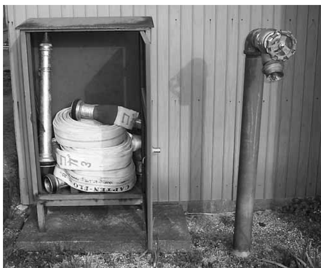
渡瀬地区消火栓
