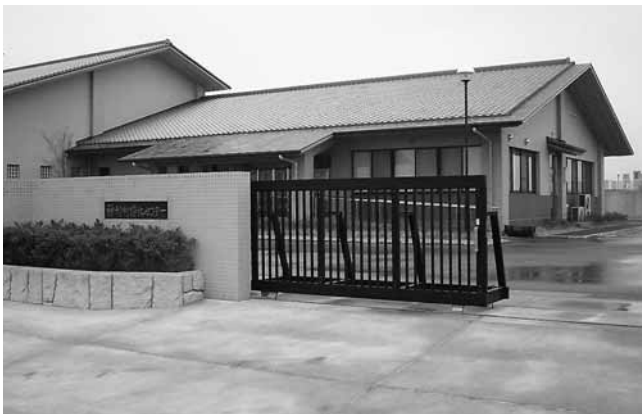
神埼下水道処理場
