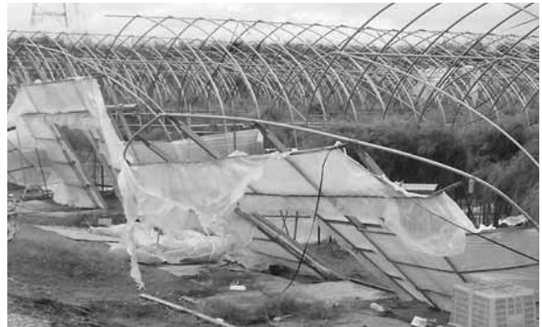
強風で被災したアスパラガスのハウス
