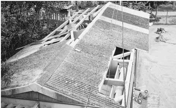
保育所小屋 屋根損壊
