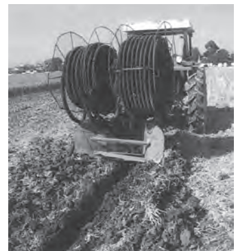
暗渠排水工事
