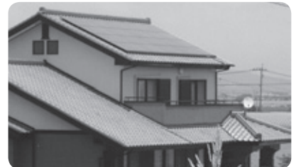
個人住宅に設置された太陽光発電システム
