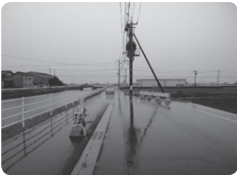
未改良区間が残る千代田西1号線 (セブンイレブンの交差点)
