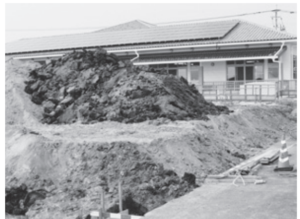
西郷保育園改築工事の現場
