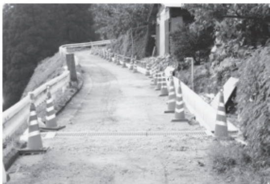
市道政所倉谷線の工事予定箇所
