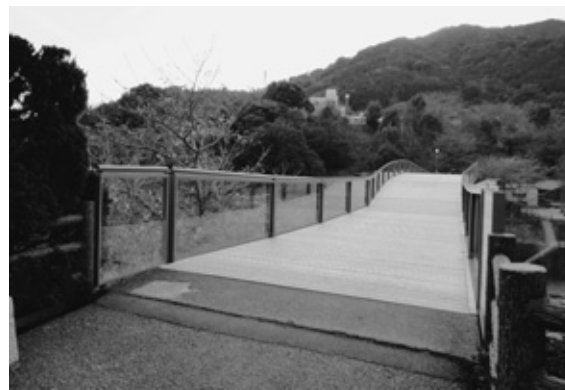
工事が終わった愛逢橋
