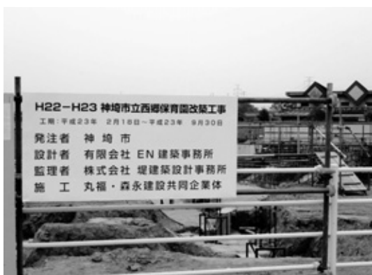
建設中の西郷保育園
