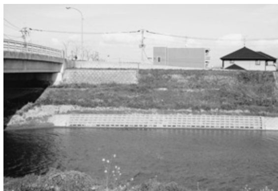
ふるさと大橋の土砂除去後
