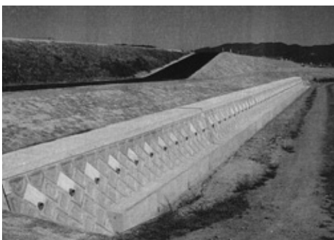
城原川 川裏補強工事
