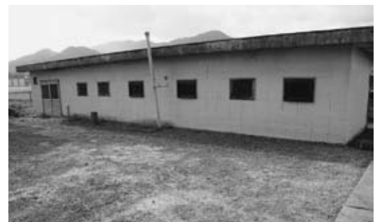
老朽化した仁比山小学校のプールトイレ
