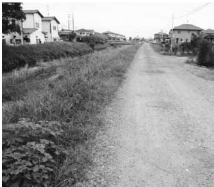
舗装が待たれる未整備道路
