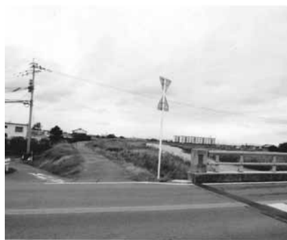
城原川堤防で一番危ない箇所「柴尾橋下流」
