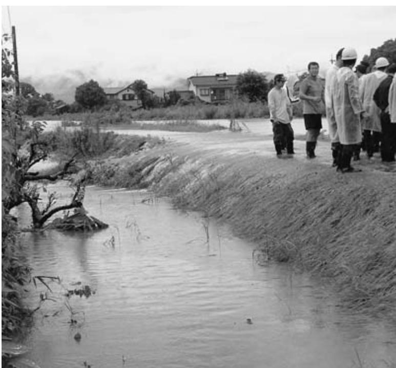
城原川堤防の越水状況（野越し）
