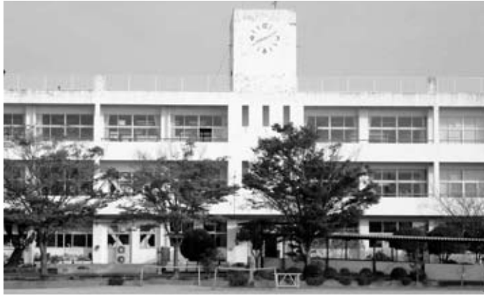
外壁の点検が行なわれる学校校舎（千代田中部小）
