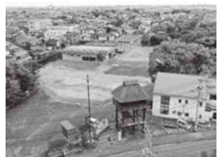
▲解体予定の南新館と旧庁舎跡地
