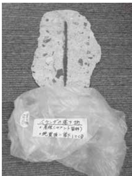
ベランダの天井より落下したコンクリート片
