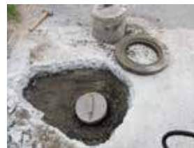
埋められた公共マス
