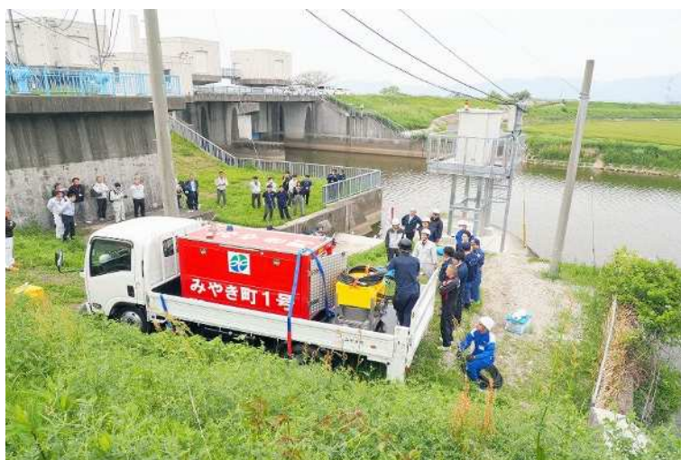
図 4-4-16 排水ポンプ車（みやき町）
