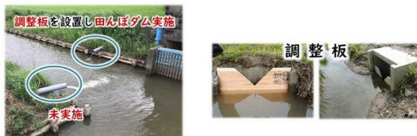
図 4-2-9 田んぼダム実施状況写真
