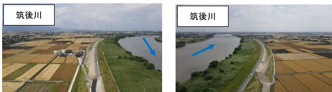
図 3-4 国管理河川の整備状況（下田地区堤防整備）
