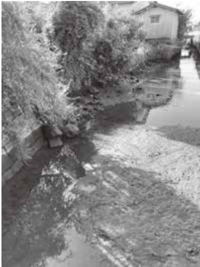
土砂が堆積し流れが悪い 地区内水路
