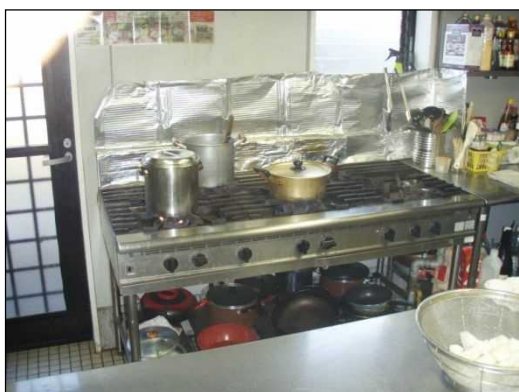
7 ガステーブル × 1 (厨房)
