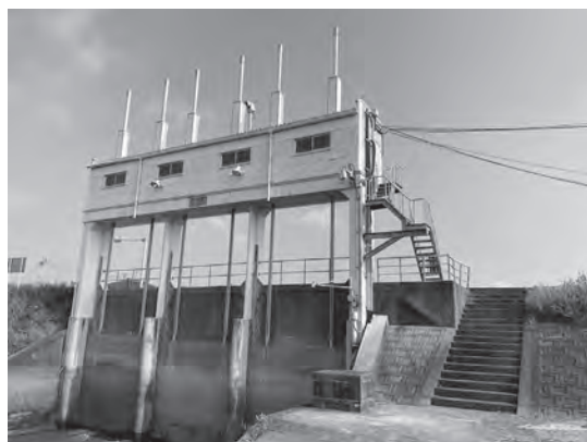
設置から86年経つ中津の浮島水門
