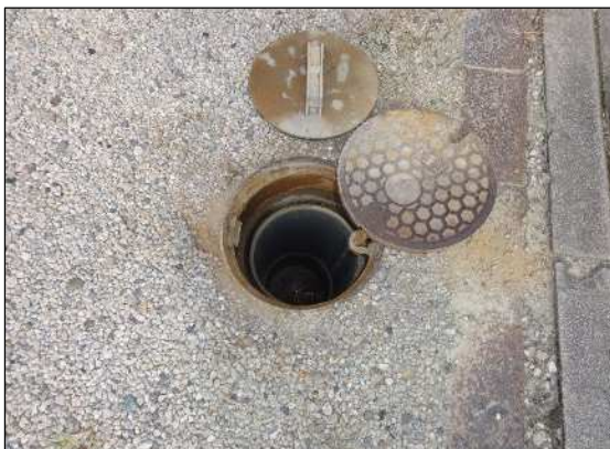
001_C_1 (ます蓋取外し状況)
