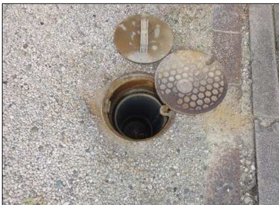
001_C_1 (ます蓋取外し状況)
