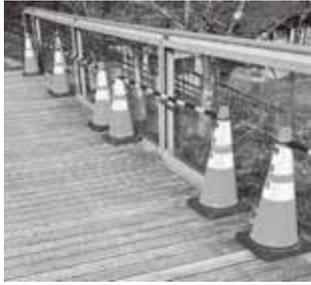
床版がひび割れ、腐食し早急な補修が望まれる。
