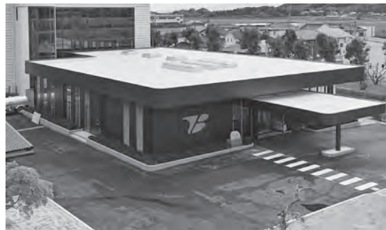
▲完成した新館
