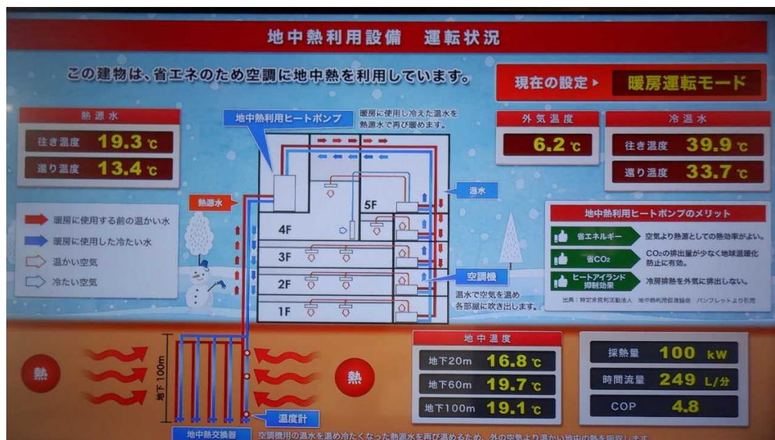
写真-1.3 地中熱ヒートポンプシステム
