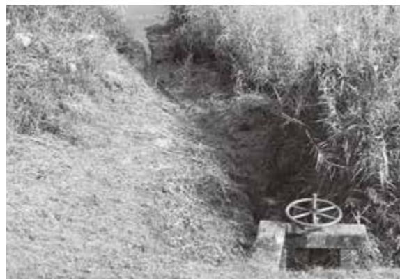
▲十二丁樋管（H30.11.27）
