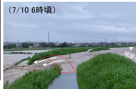
令和5年7月洪水 4号野越しからの越水状況
