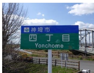
地区看板改修工事
