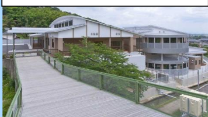
神崎市憩の家給湯設備工事事業
