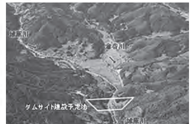
■空から見た城原川ダム予定地付近
