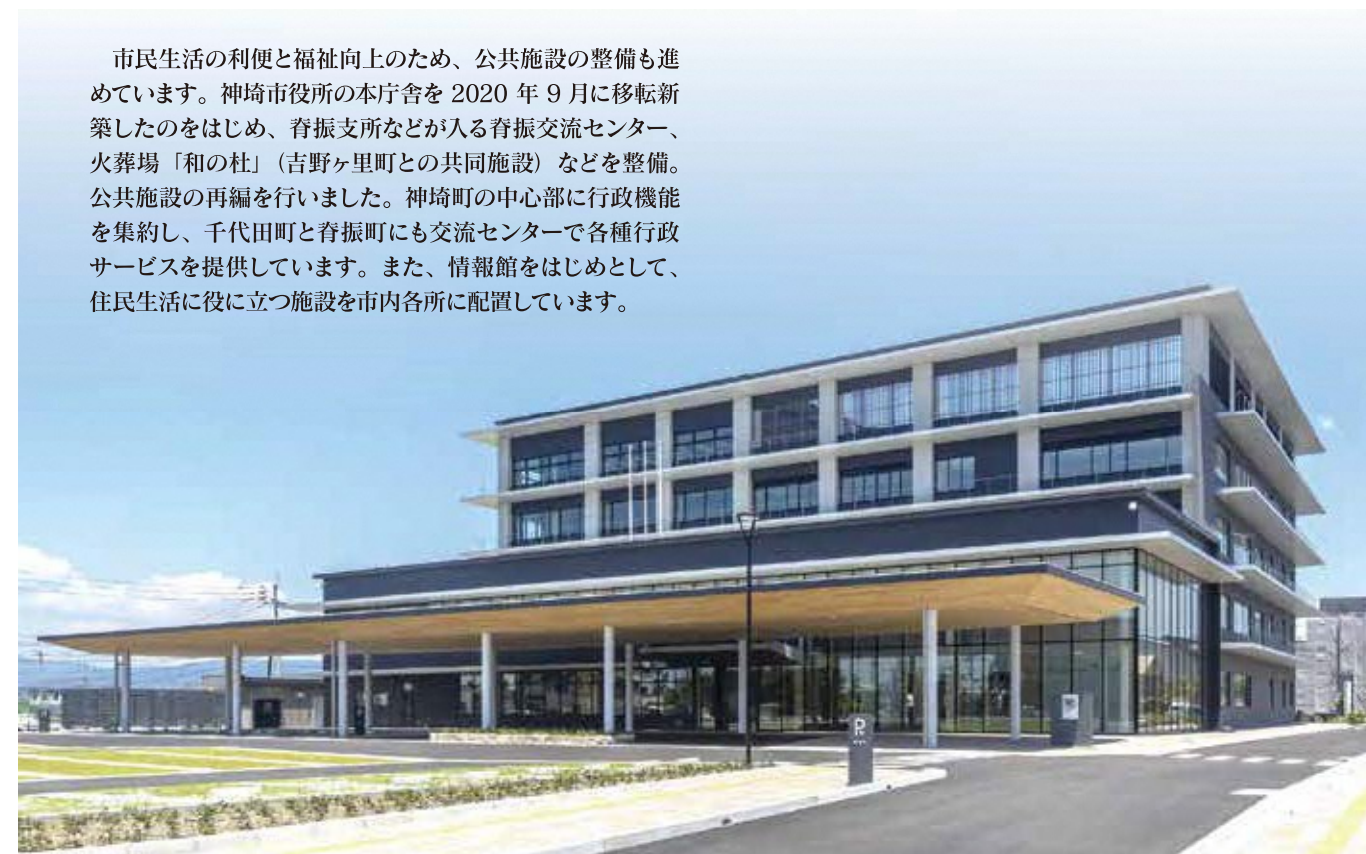
2020 年 9 月に移転新築した市役所本庁舎
