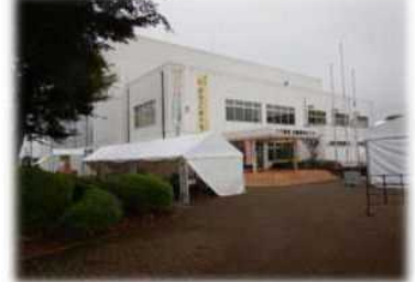
下野市石橋体育センター
