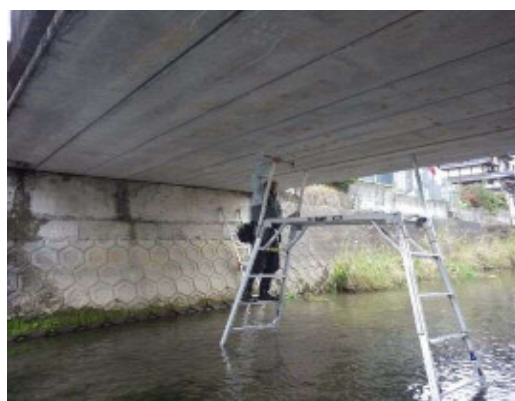
定期点検（打音検査）状況
