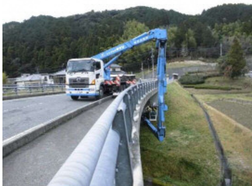
橋梁点検車による定期点検
