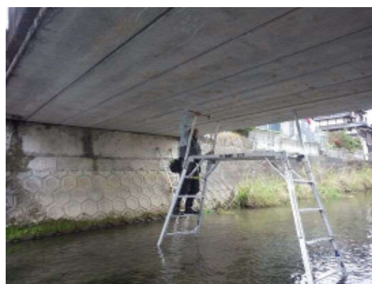
定期点検（打音検査）状況
