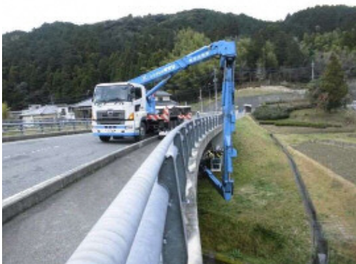
橋梁点検車による定期点検
