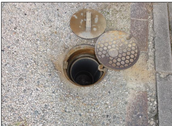
001_C_1 (ます蓋取外し状況)
