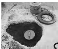
▲埋められた公共マス
