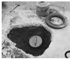
▲埋められた公共マス
