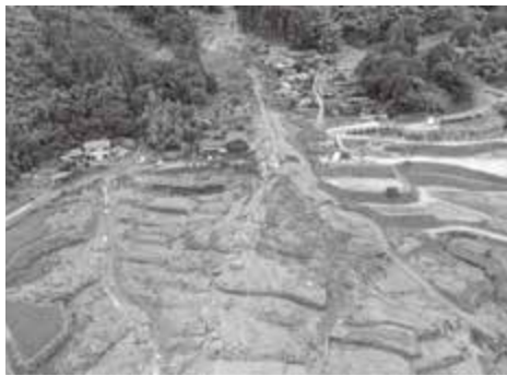
甚大な災害となった三谷集落の土石流
