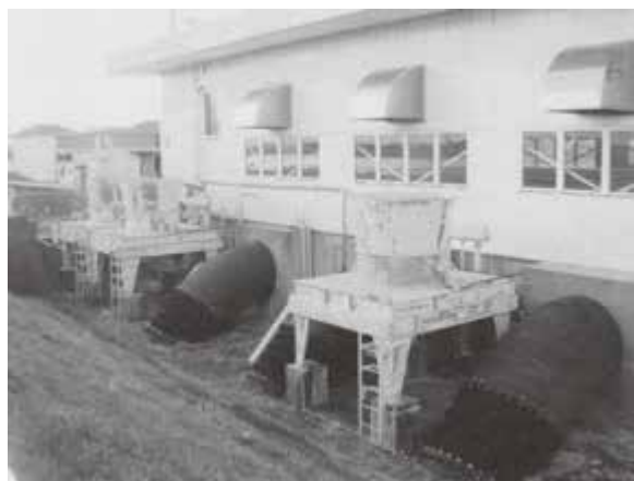
各排水機のポンプの能力アップと新たな新設が望まれている。
