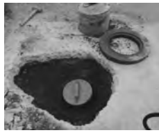
埋められた公共マス
