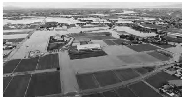
千代田町内（田手川左岸）の冠水状況
