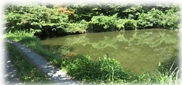
日の隈下ため池
