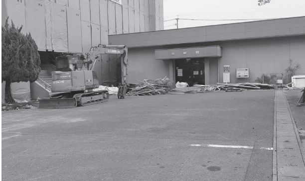
解体が進む旧本庁舎と残置予定の南新館
