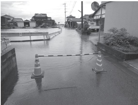
黒津地区から嵩上げ要望が出されている 浸水した集落の生活道路
