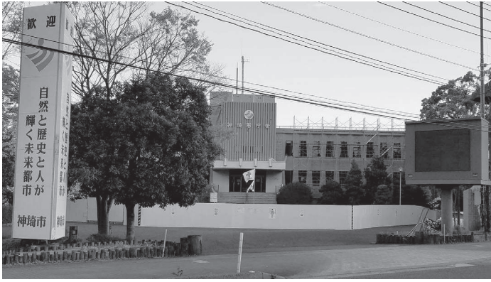
解体が進む旧神崎市役所本庁舎
