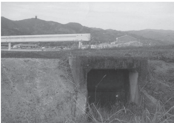
ECO・DRRの取り組みの一つである野越の霞堤下部にある招き扉(現在はほとんど機能していない)
