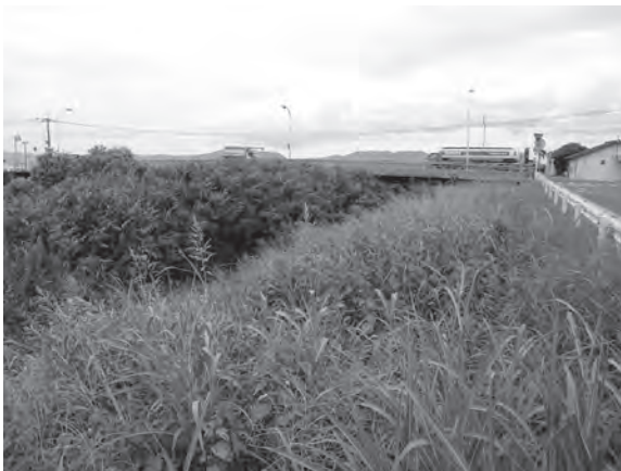
城原川(直鳥橋付近)に繁茂している樹木群
